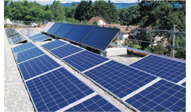
La bâtiment de la voirie a été équipé en panneaux thermiques et solaires en juin 2013.
