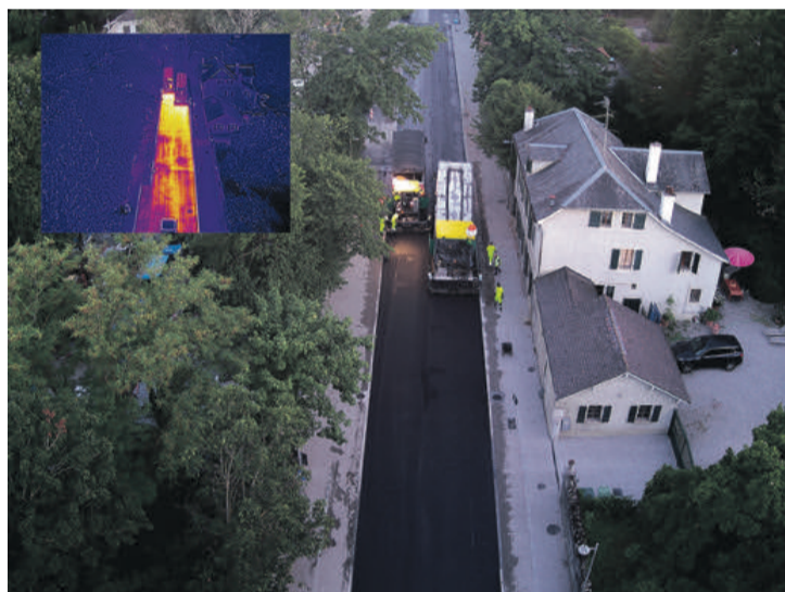
Pose du revêtement phonoabsorbant de nuit sur les phase 1 et 2 (rte de Sauvigny - frontière vaudoise).
