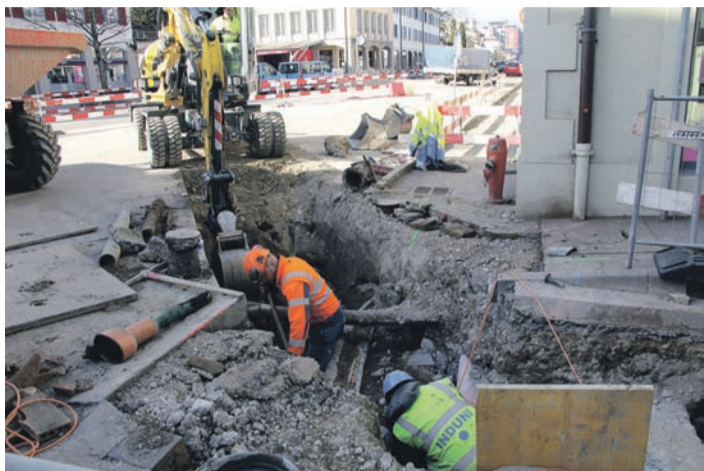
Travail sur le collecteur à la sortie du quai de Versoix (côté Lausanne)
