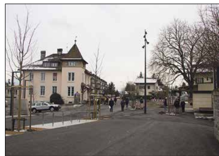
La placette de la gare est désormais terminée ainsi que l'ensemble des aménagements du chemin Vandelle. Des conteneurs enterrés ont été implantés entre le chemin César-Courvoisier et la rue des Moulins.
