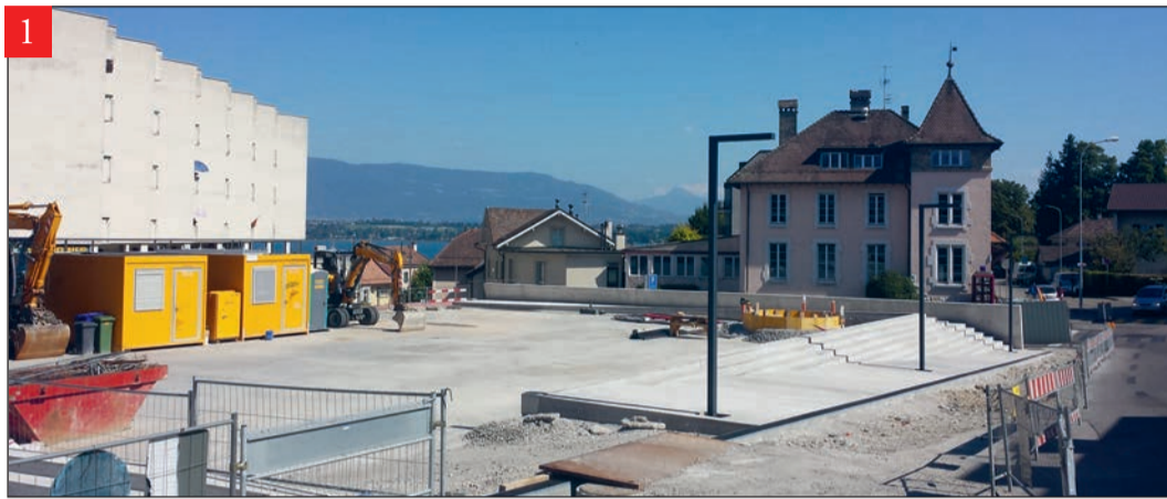
1 Un aperçu des travaux avec le chantier de la place de la gare qui se poursuit selon les délais.
