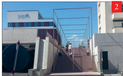
2 Les escaliers menant à la poste sont terminés.
