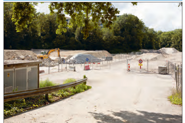
Ce chantier doit permettre de limiter les risques d'inondation dans cette zone tout en favorisant l'accueil du public.
