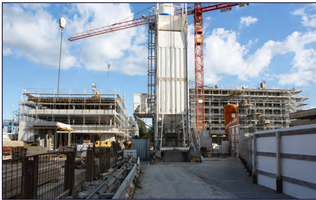
Versoix centre-ville prend forme avec, à gauche, le futur bâtiment administratif et commercial et, à droite, le futur hôtel.
