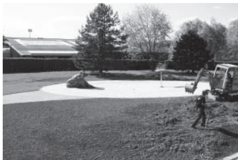
Vue sur la nouvelle patageoire
